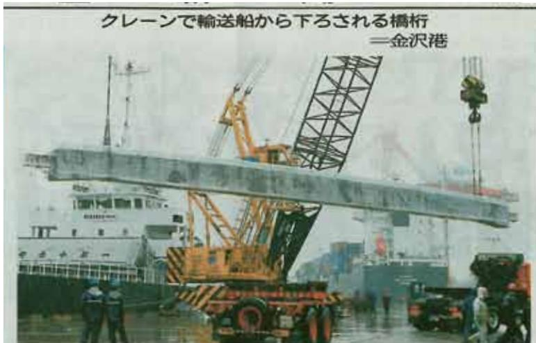
クレーンで輸送船から下ろされる橋桁
